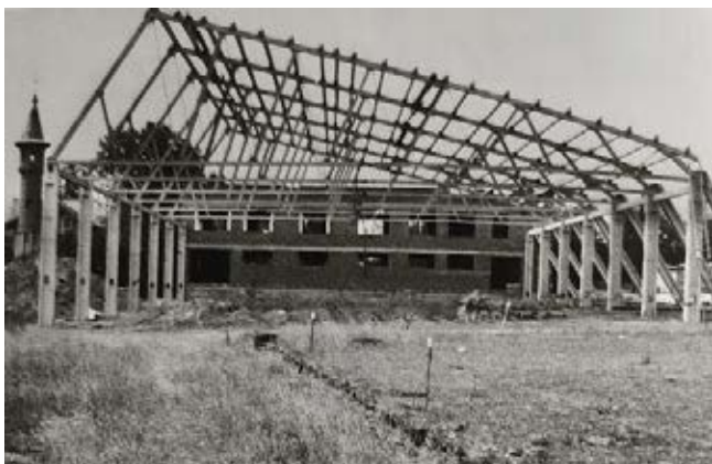
Construcció de l'estructura de la piscina. Font: llibre Sandra Adam: Puigcerdà, recull gràfic (1897-1977) .
