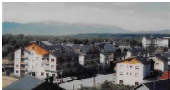
Fotos 10 (Primera construcció a la carretera) i 11 (Següents construccions).
