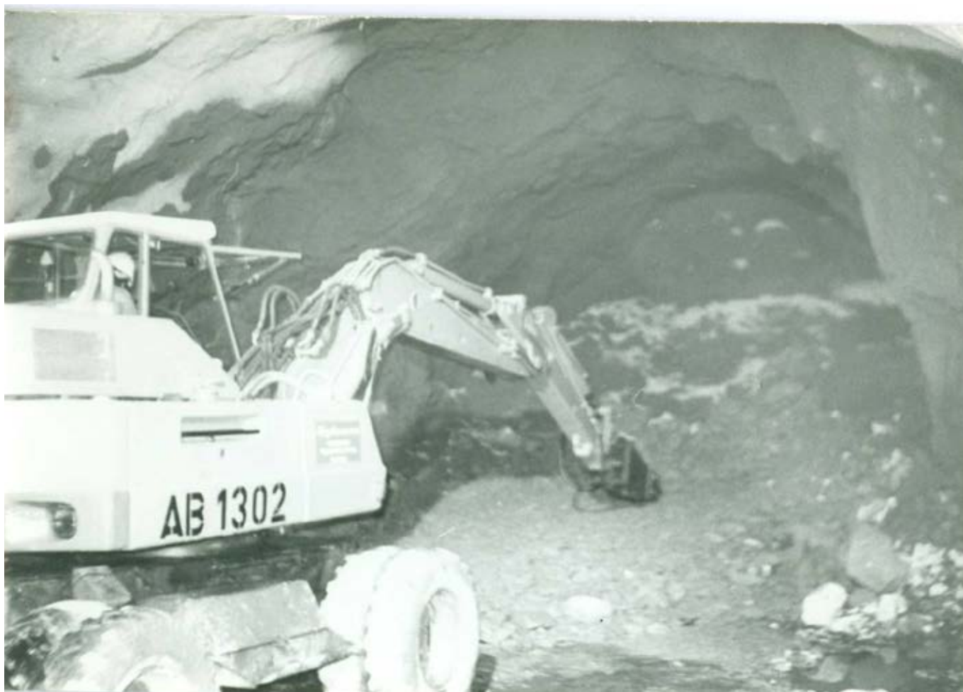
Una màquina comença a perforar l'últim tram del túnel (1984). Foto: ACCE
