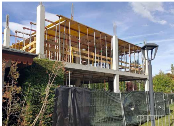
Pisos de luxe en construcció als afores de Puigcerdà (F: Francesc Esteban).
