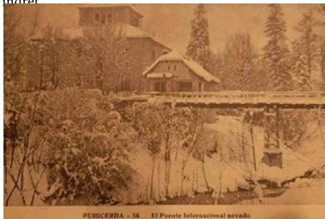
Edifici de control de la Duana, situat en un extrem de la finca de la Torre Grau. Autor desconegut (Fons Martí Solé Irla).
