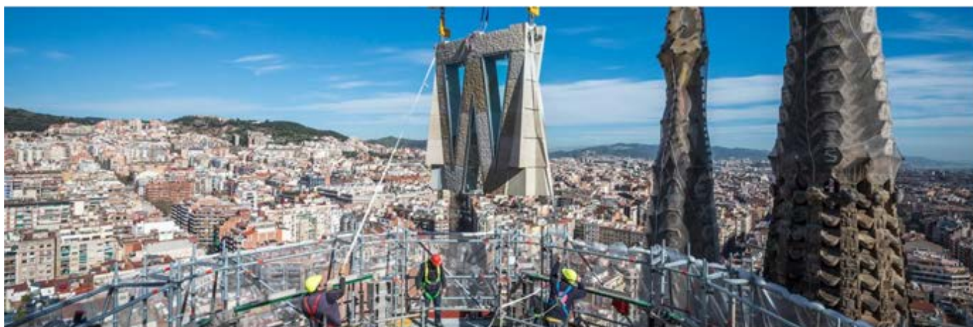
El temple en construcció. Col·locació de plafons prefabricats de les torres. Font: Sagrada Família
