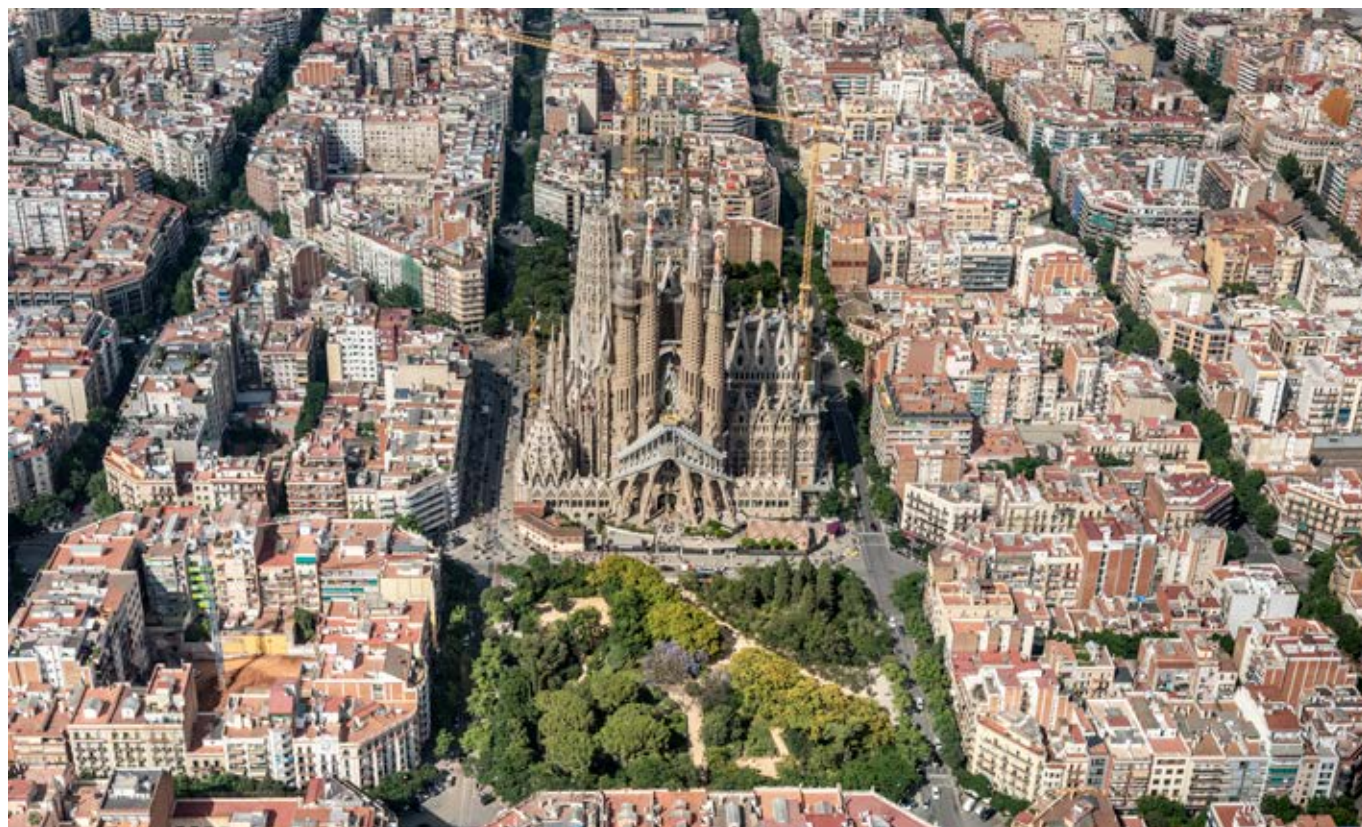
Estat actual del Temple amb les torres dels Evangelistes, Mare de Déu i Jesucrist en construcció.
